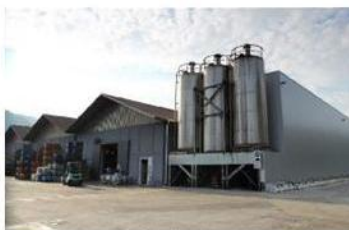
Uno scorcio degli impianti delle Fonderie di Montorso
