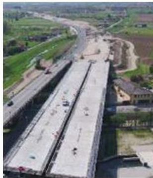
Il cantiere della Pedemontana
