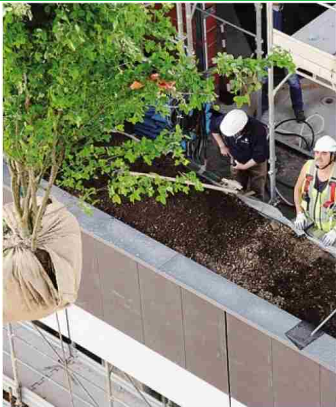
Il cantiere del bosco verticale, uno dei progetti di punta al quale ha partecipato la Peverelli
