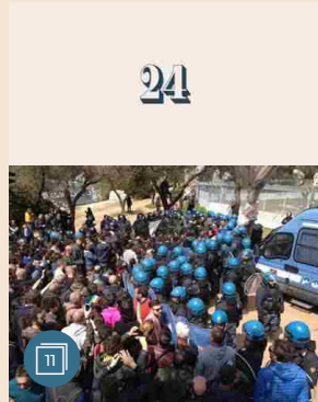
ATTUALITÀ | 28 marzo 2017 Tap, scontri nel cantiere per il via libera al trasloco di 200 ulivi
